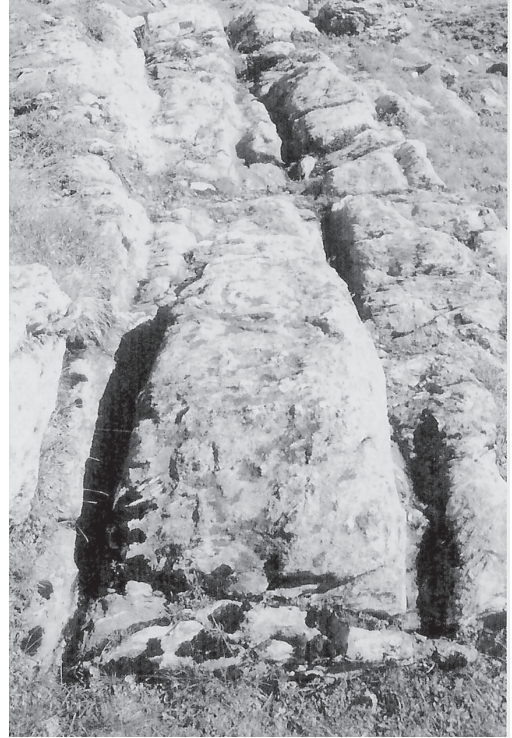
Carreggiate dei carri che nel Medioevo percorrevano il Settimo, presso Bivio. La distanza tra i due solchi è regolare, 107 centimetri circa. Foto ADGR.
