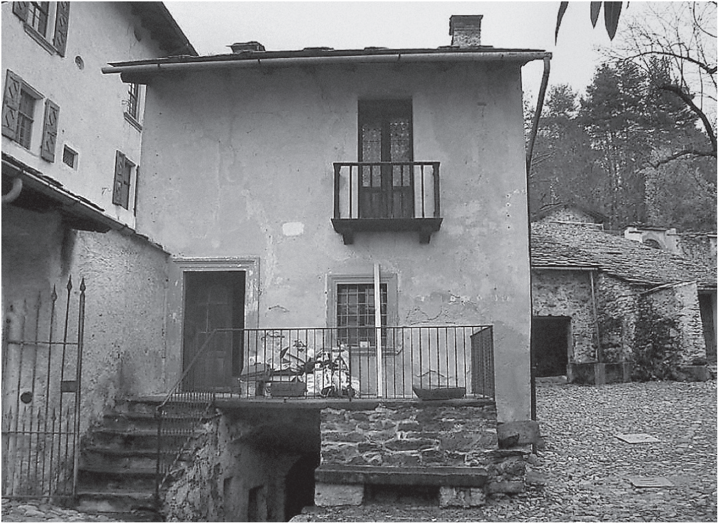
Edificio A. Ex casa custode, prospetto sud-ovest.
