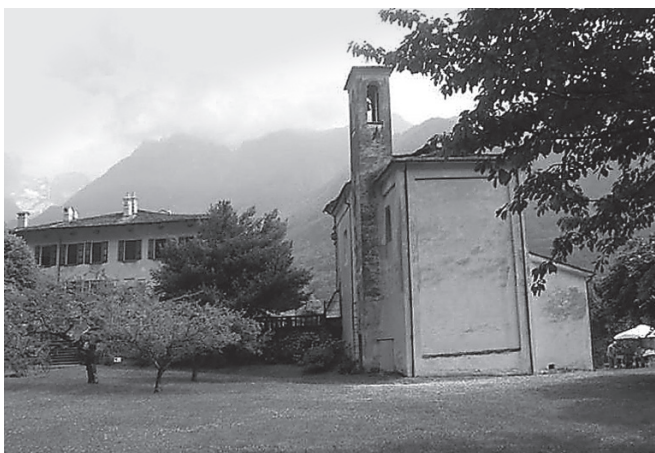
Edificio H, Prospetto Nord.
