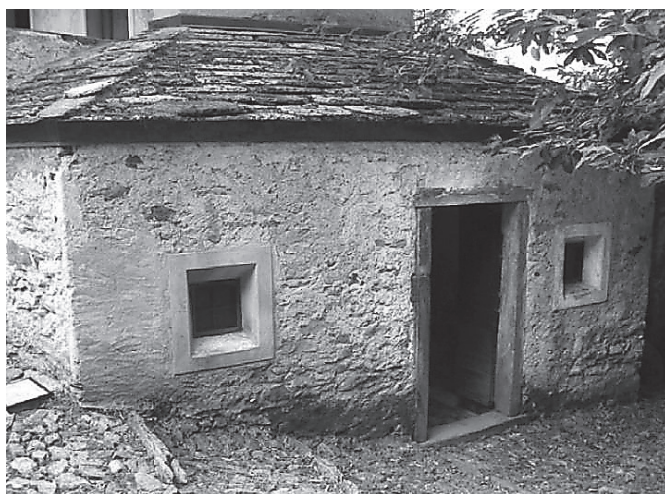
Edificio C, Prospetto Nord.
