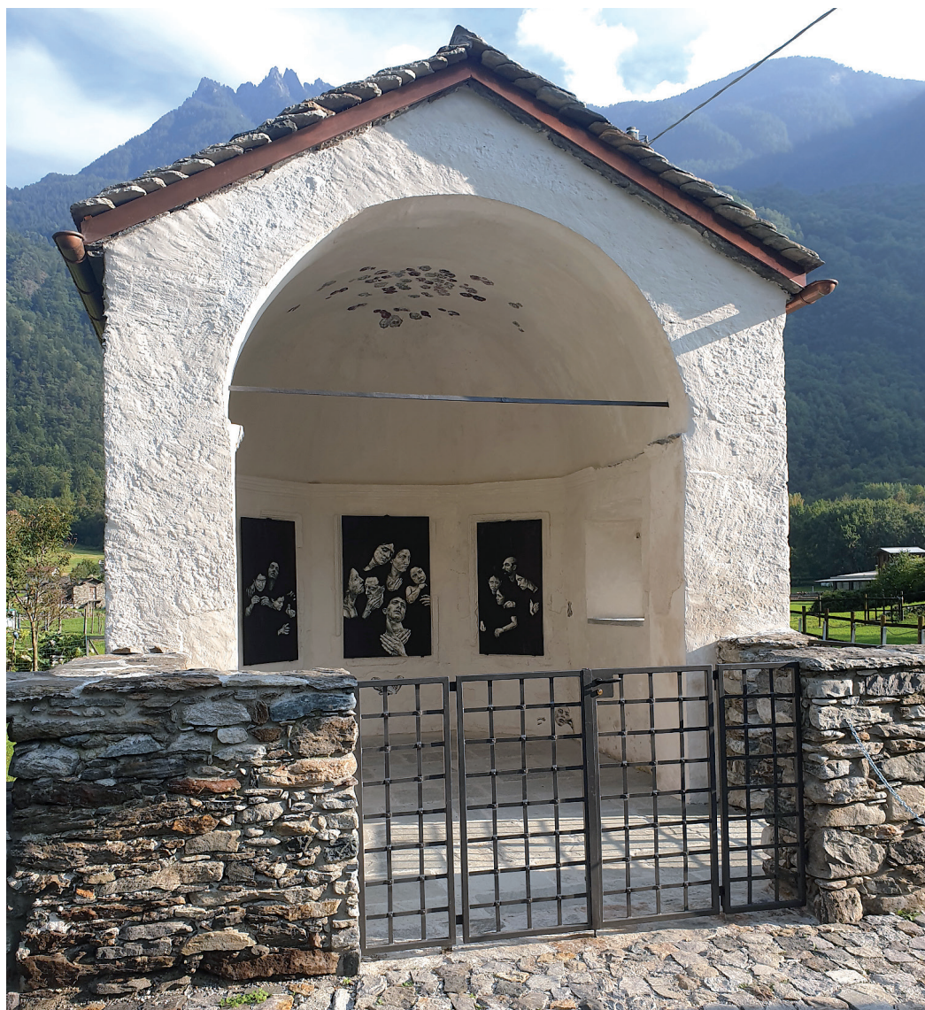
La cappella dopo il restauro del 2019.
