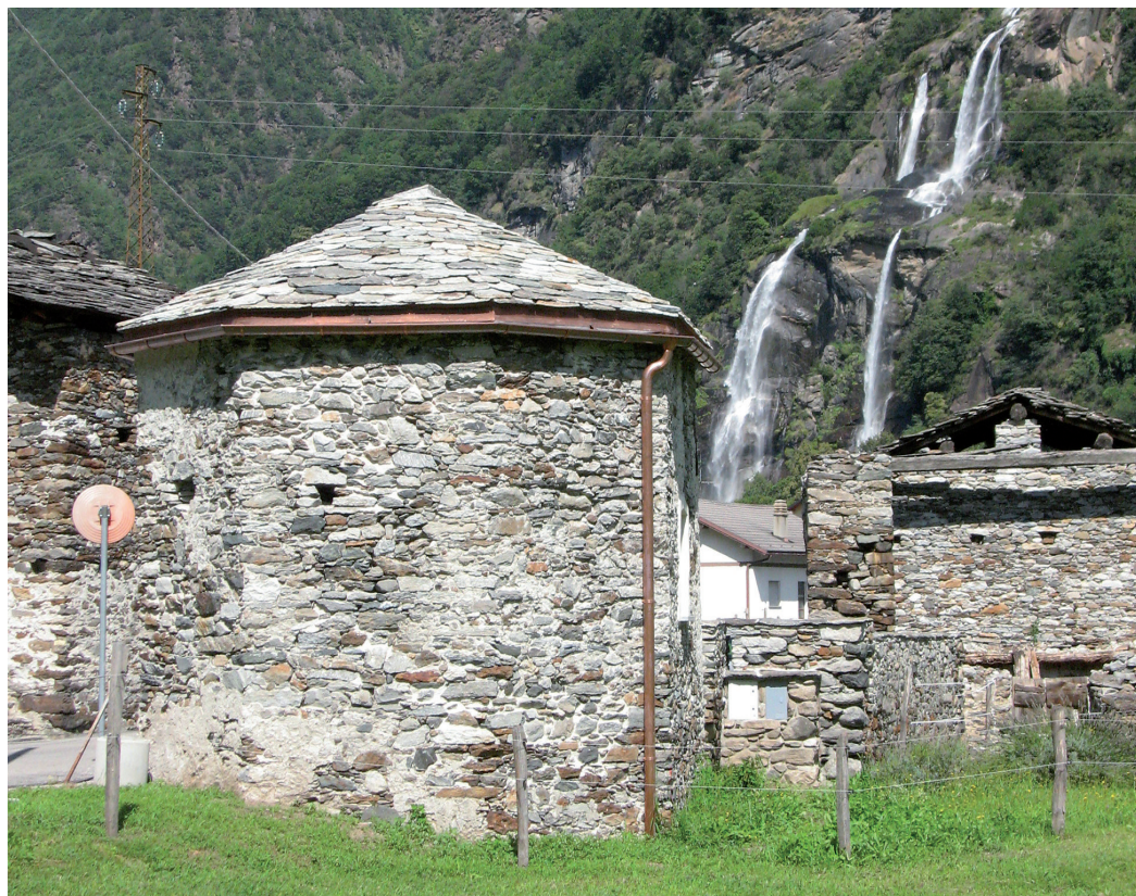
L'abside della cappella dopo il restauro del 2019.
