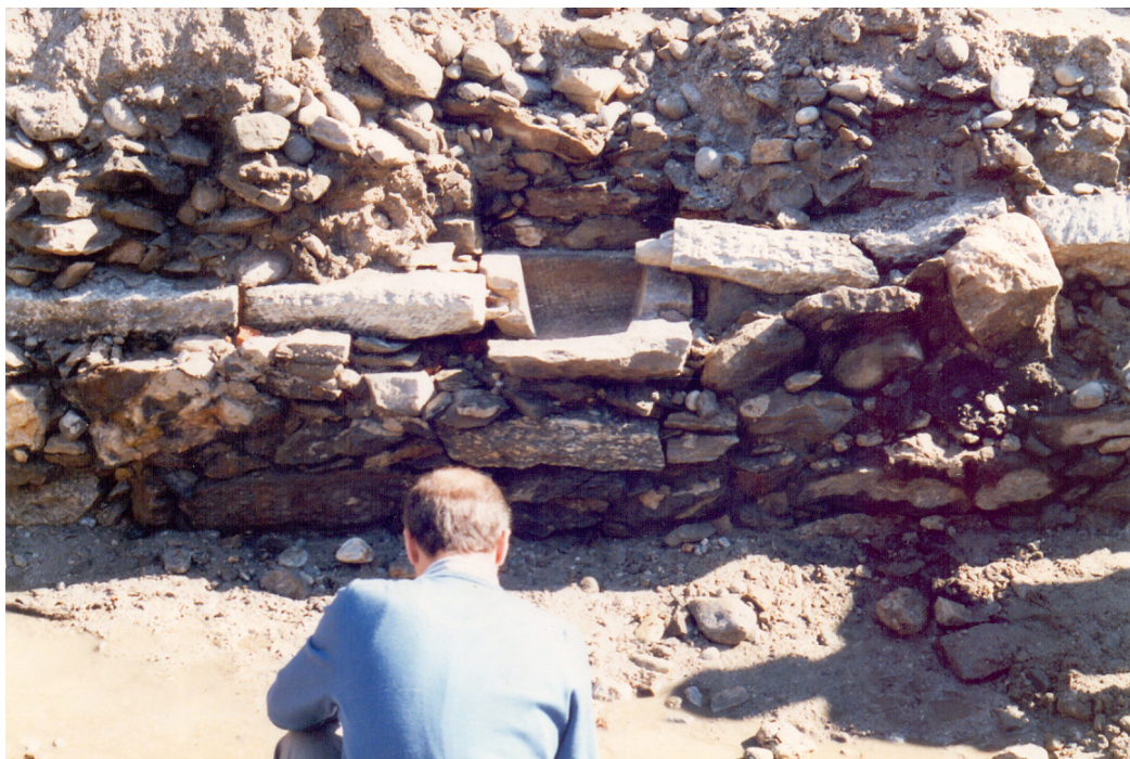
Figura 5: Particolare del deviatore a T.
