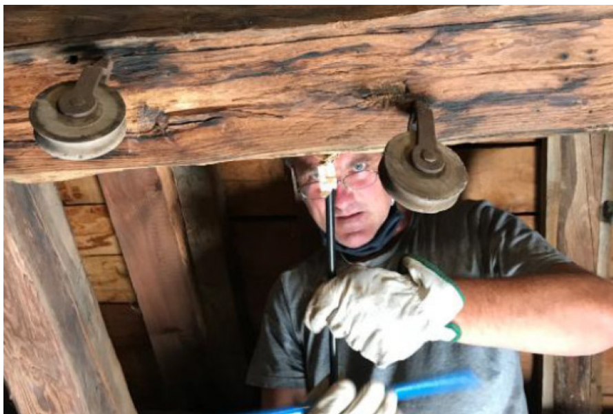
Chiesa di San Martino. Una ditta specializzata preleva dei campioni dalle parti lignee del tetto per analizzarle.
