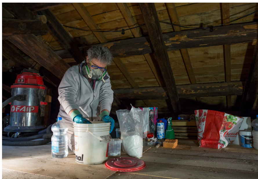
Chiesa di San Martino, sottotetto. La restauratrice prepara il materiale per l'impacco di pulitura.
