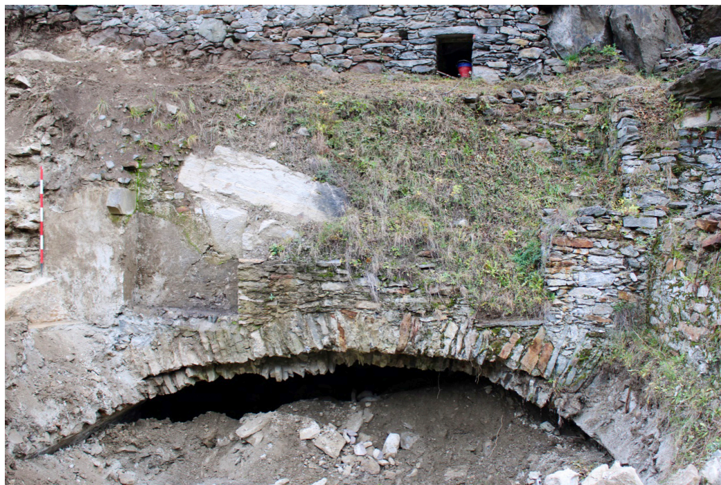
Fig. 2. Piuro (SO), Cantina del Piocc, Area 2000, Settore Gamma, perimetrale nord.
