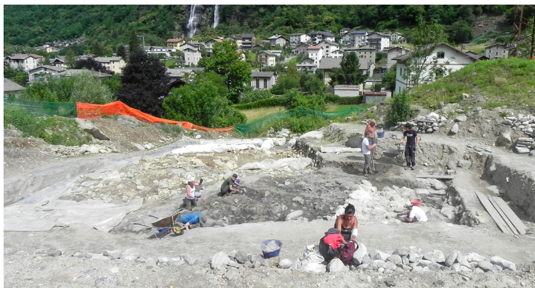
Fig.3: Località Mòt del Castèl: sito interessato agli scavi
