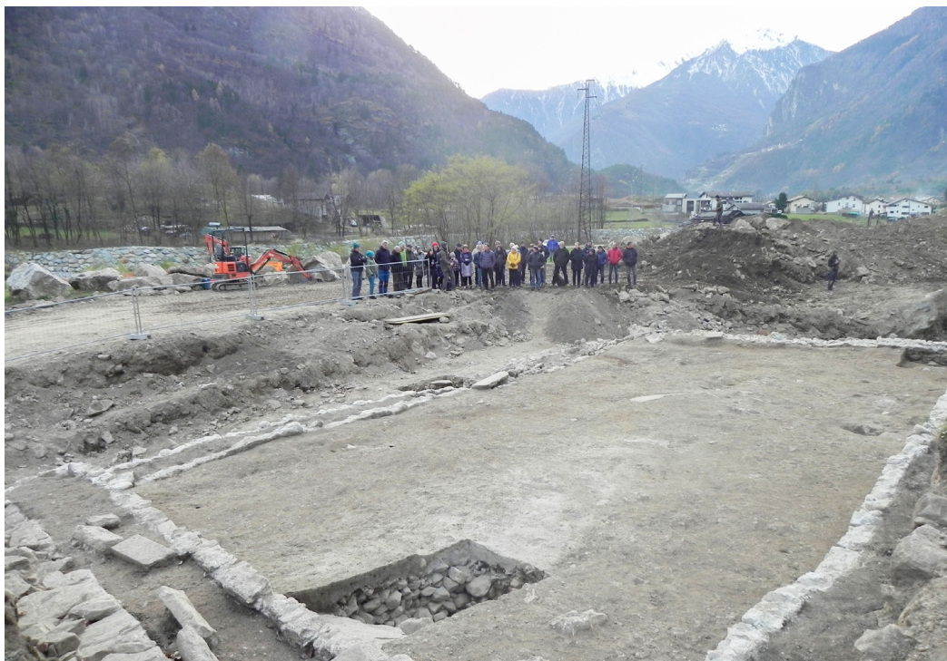
Fig. 19. Visita agli Scavi Archeologici del Palazzo Bavele.
