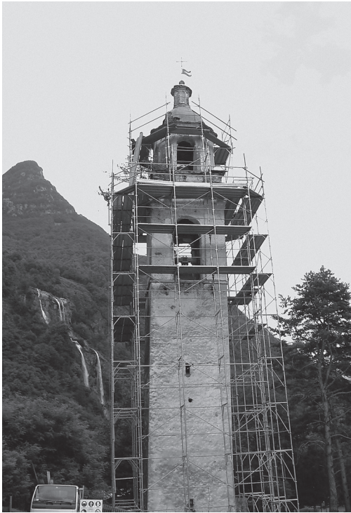
Il ponteggio attorno al campanile prima del taglio del pino.
