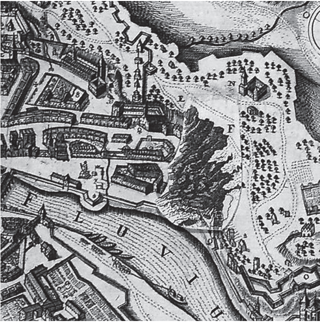
2. Das Bergsturzgebiet, Detail aus Abb. 1. - L'area della frana, dettaglio della figura 1.
