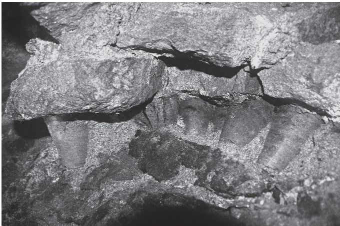
Pavimentazione a bottoni, vista da sotto in su, adiacente alla Volta.
