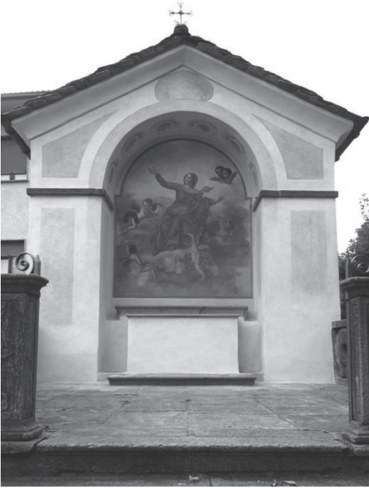
La Cappella dei Cenni dopo il restauro
