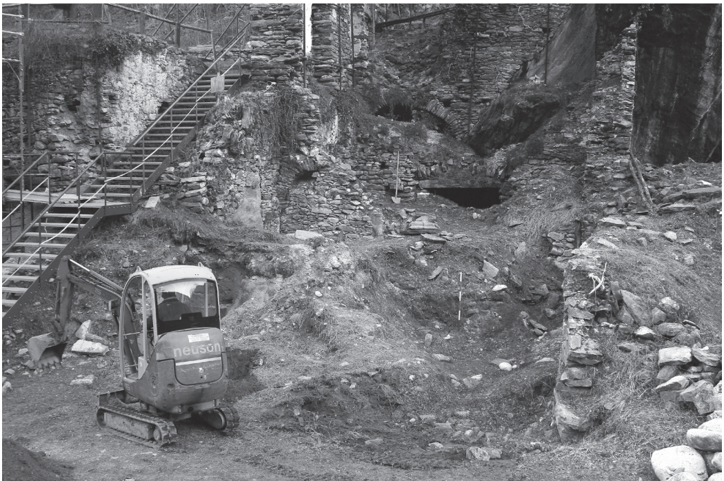
Fig. 5 - Il complesso “Belfort” agli inizi delle operazioni di pulizia.
