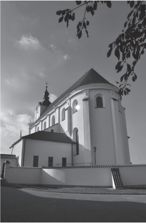
Fot. 1 - Siemiatycze, chiesa parrocchiale dell'Assunzione della Vergine. Vista da est. Fot. S. Kłosowski.
