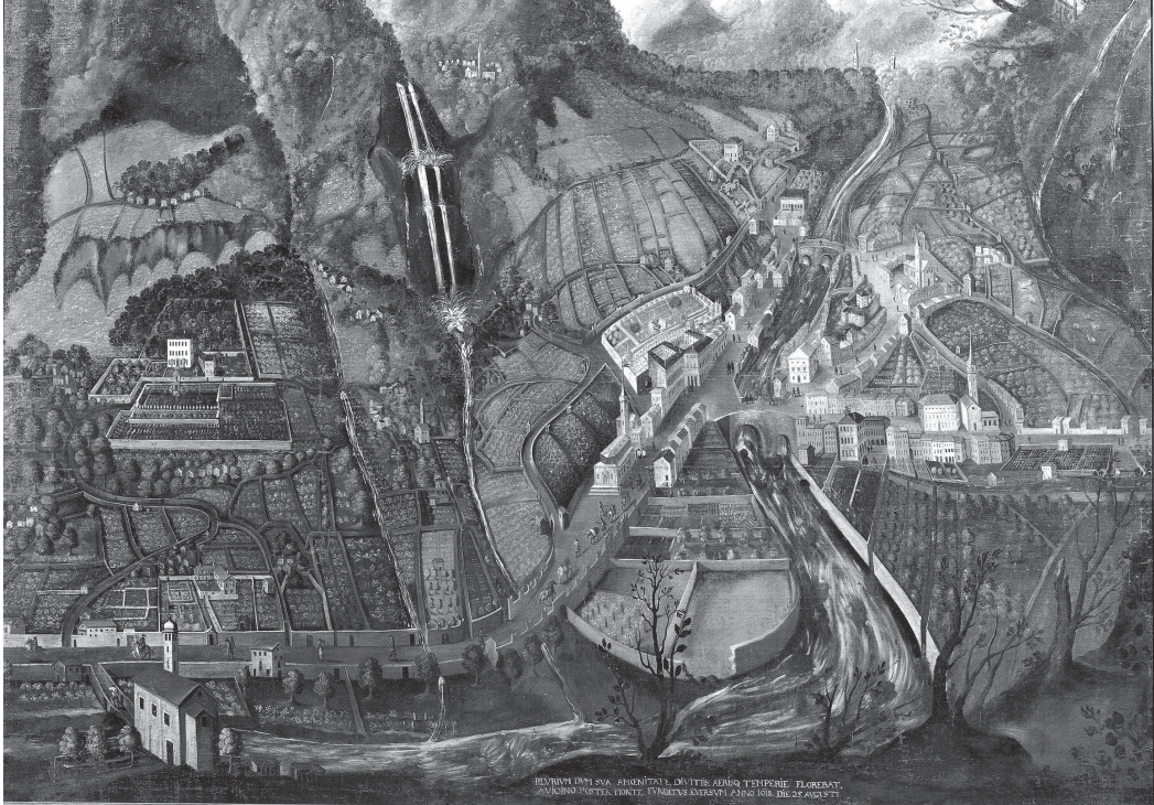
Fig. 1 - Veduta ricostruttiva di Piuro realizzata dopo la frana. È plausibile che il complesso “Belfort” corrisponda al palazzo con giardino recintato, situato in destra Mera poco dopo il secondo ponte (Prosto, Palazzo Vertemate, circa metà XVII sec.).
