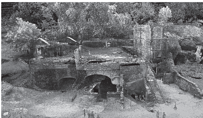
Fig. 8 - Rilievo laser scanner dei ruderi Belfort.
